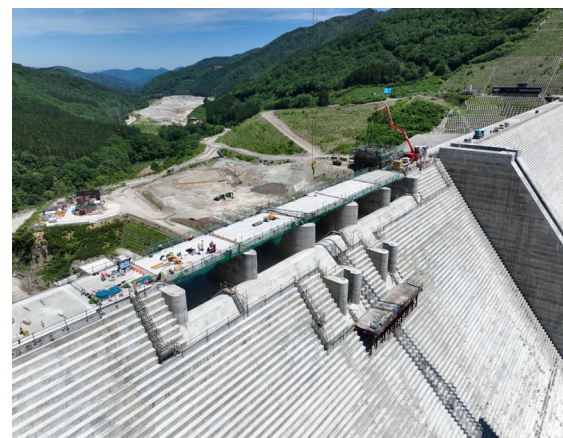
【堤体洪水吐の上に橋が架かり左右岸が繋がりました】 2026年6月1日 撮影
