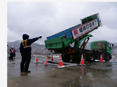
現場製造コンクリートの 最終打設の様子
