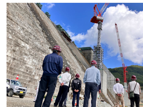
【上流側から見上げる堤体】 2025年9月26日 撮影
