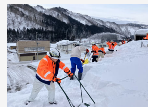
【ゆるるんの雪下ろしの様子】 スノーダンプや小型の除雪機を屋根の上において作業を行いました。
