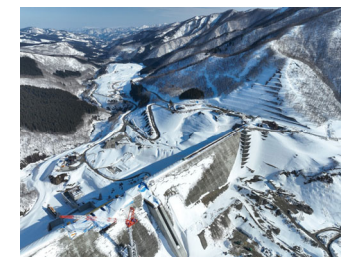
【堤体上流より 右岸】
