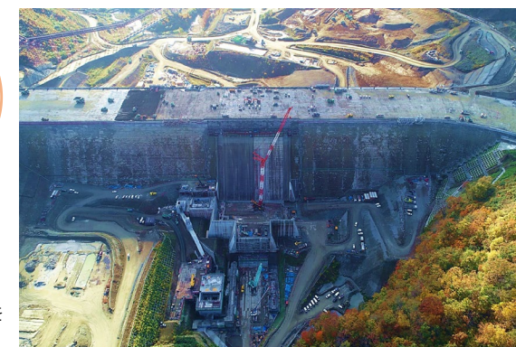
減勢工（施工状況） 2023年11月撮影
