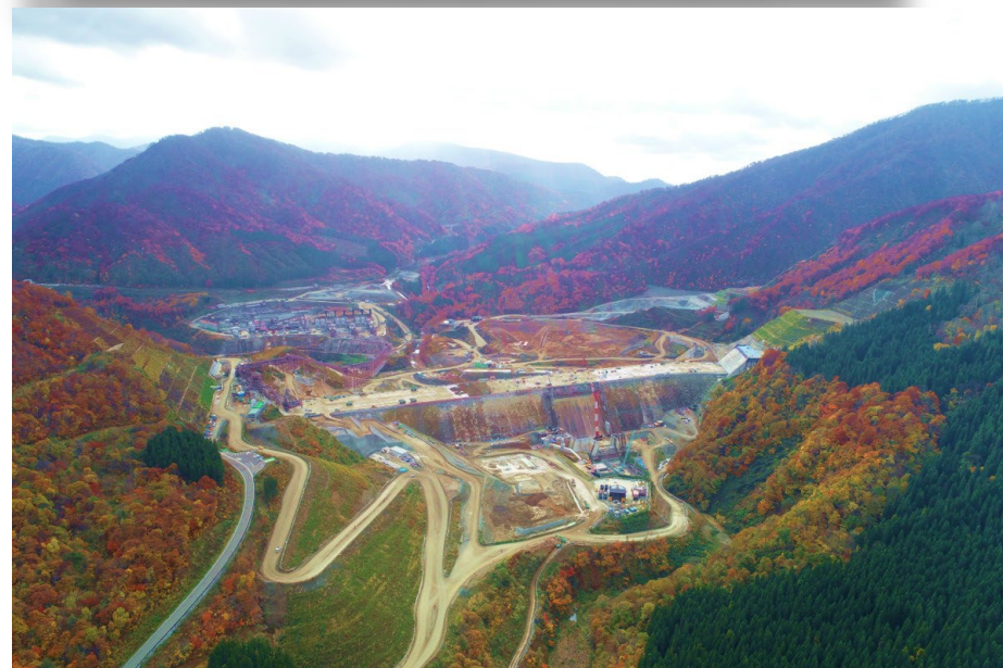
ダムサイト全景（下流より）2023年11月撮影
