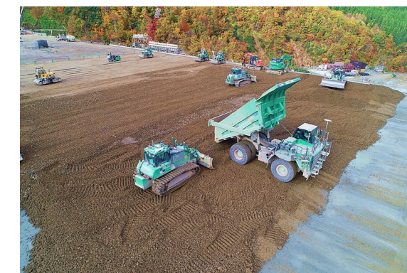
堤体上（施工状況） 2023年11月撮影
