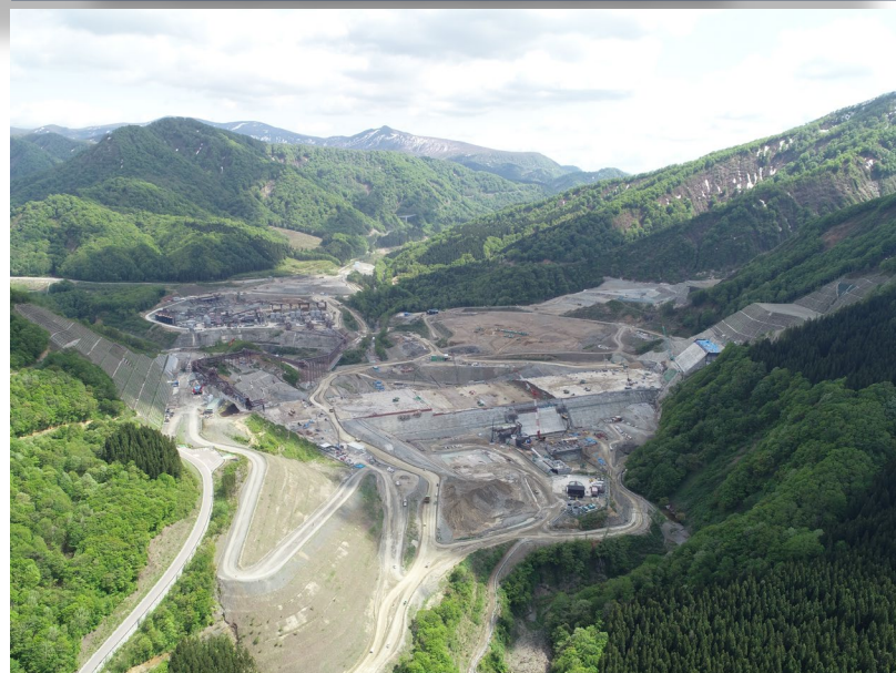
ダムサイト全景（下流より）2023年5月撮影
