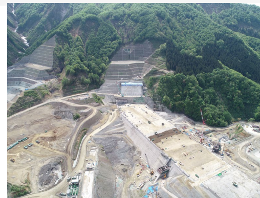
左岸（施工状況） 2023年5月撮影
