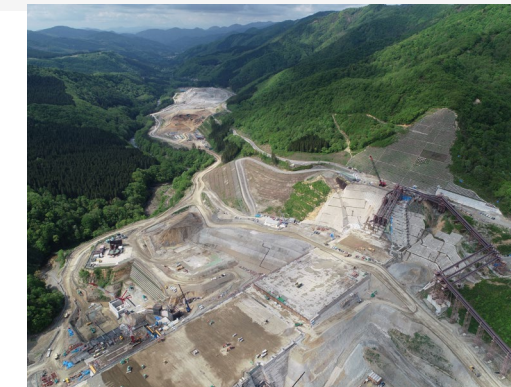
右岸（施工状況） 2023年5月撮影
