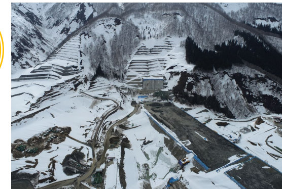
左岸（施工状況） 2023年3月撮影
