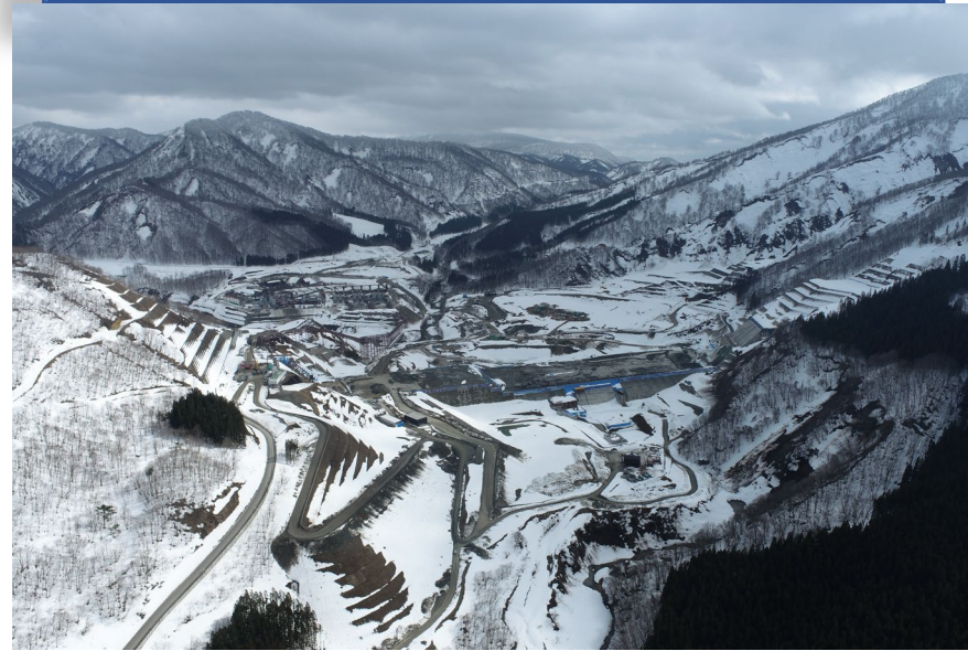
ダムサイト全景（下流より）2023年3月撮影
