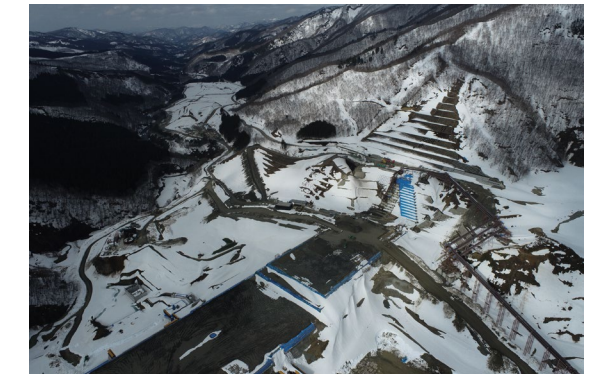
右岸（施工状況） 2023年3月撮影
