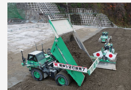
【11/7堤体1/2打設完了式】 242.5万㎡となるCSGを打設している様子 ブルドーザーはA・CSELによる自動運転
