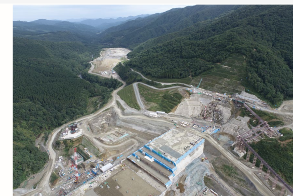
右岸（施工状況） 2022年9月撮影
