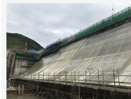
【洪水吐施工状況】 現場では着々と施工が進んでいます！
