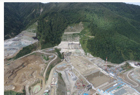
左岸（施工状況） 2022年9月撮影
