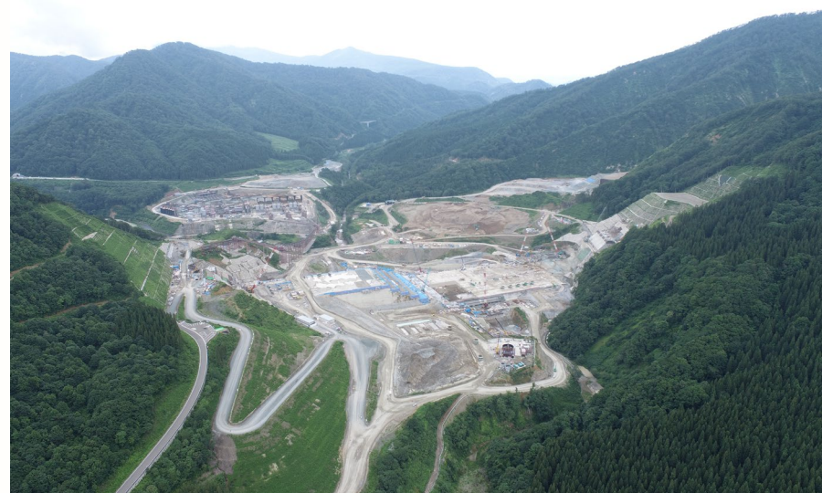
ダムサイト全景（下流より）2022年7月撮影
