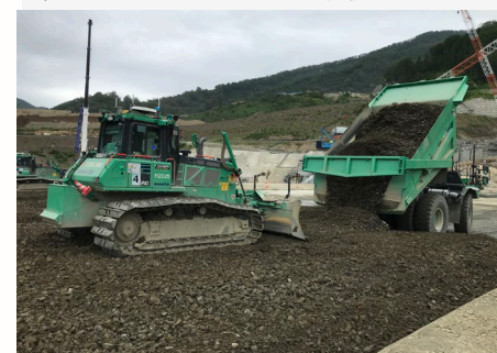
【2022年6月のCSG打設の様子】 鹿島の誇る自動化施工技術「A*CSEL」により 引き続き超高速施工を進めています。
