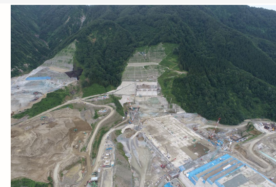
右岸（施工状況） 2022年7月撮影
