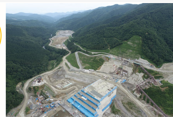
左岸（施工状況） 2022年7月撮影
