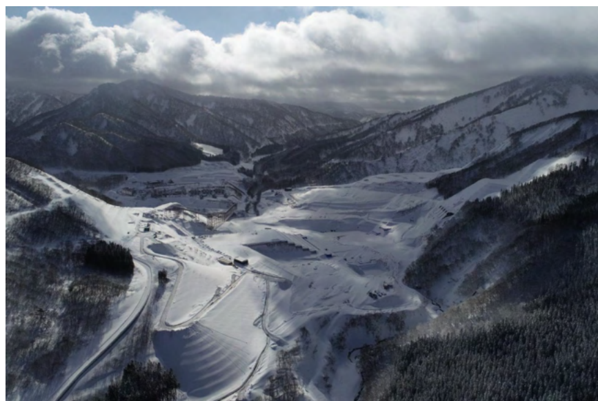
ダムサイト全景 (下流より) 2022年1月撮影
