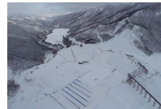
右岸 (施工状況) 2022年1月撮影
