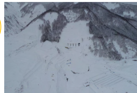
左岸 (施工状況) 2022年1月撮影
