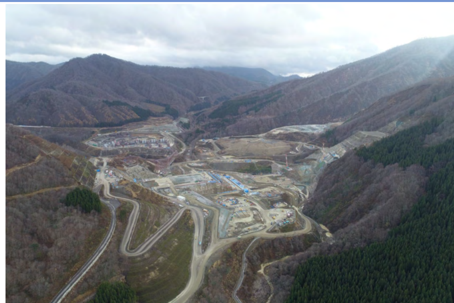
ダムサイト全景（下流より）2021年11月撮影
