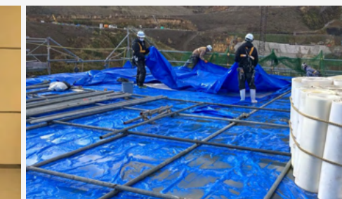
【堤体の凍結防止養生の様子】
