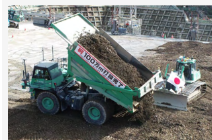
【100万m 3 打設完了式】
