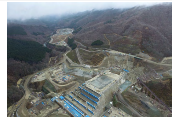
右岸（施工状況） 2021年11月撮影
