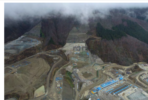
左岸（施工状況） 2021年11月撮影
