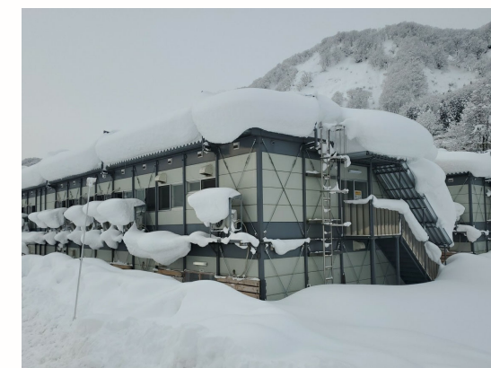
事務所宿舎ヤードの積雪状況 (1月5日時点)
