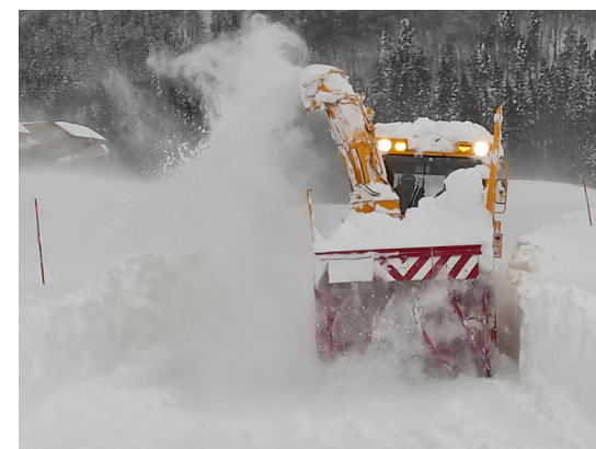
現場内の除雪状況 (赤滝プラントヤード)
