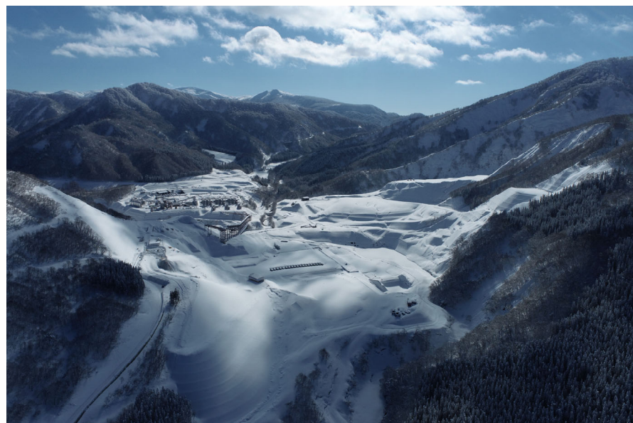
ダムサイト全景（下流より）2021年1月撮影
