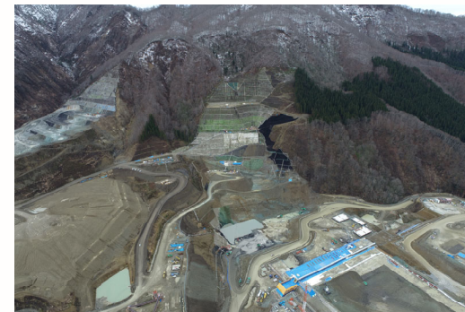
左岸 (施工状況) 2020年11月撮影
