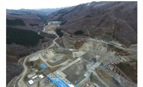
右岸 (施工状況) 2020年11月撮影
