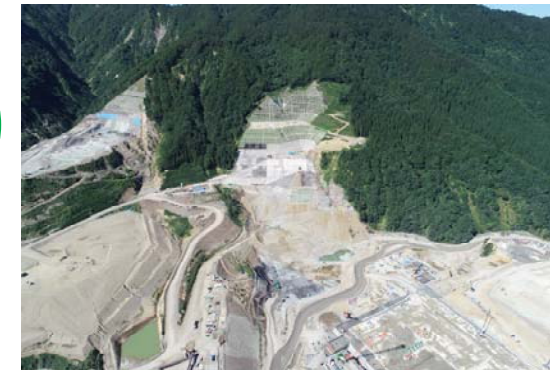
左岸 (施工状況) 2020年9月撮影
