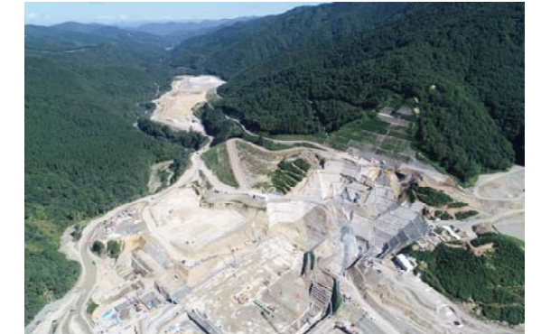
右岸 (施工状況) 2020年9月撮影
