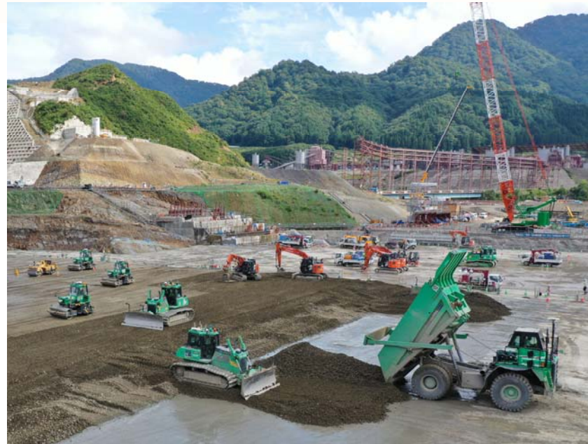
A+CSELによる堤体打設の状況 (2020年9月撮影)
