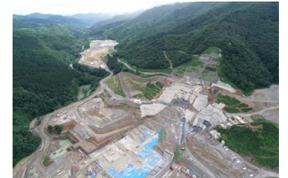
右岸（施工状況） 2020年7月撮影
