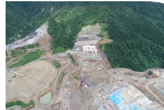
左岸（施工状況） 2020年7月撮影
