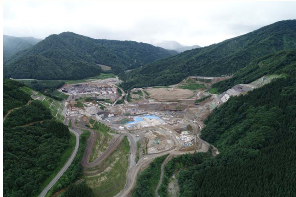
ダムサイト全景（下流より）2020年7月撮影
