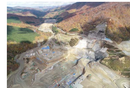
右岸（施工状況） 2019年11月撮影
