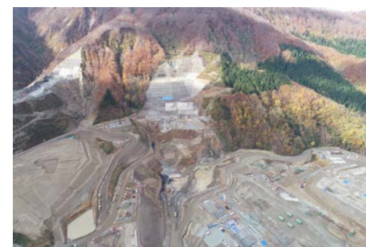
左岸（施工状況） 2019年11月撮影
