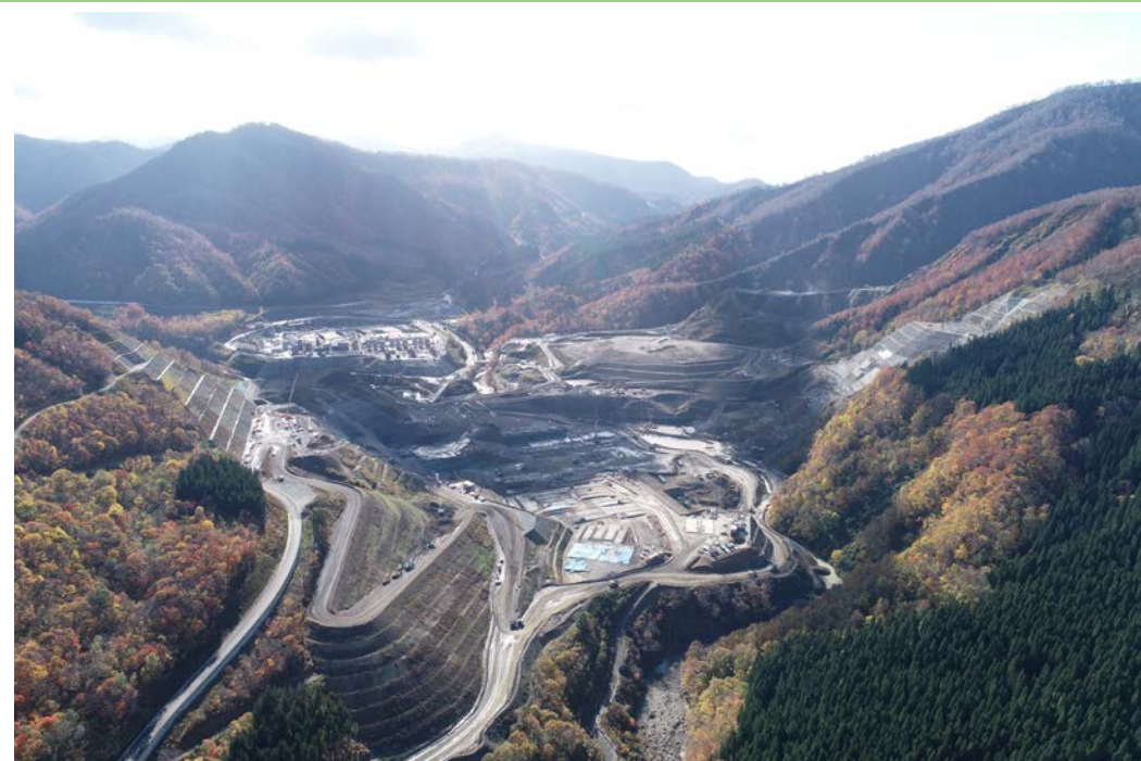
ダムサイト全景（下流より）2019年11月撮影
