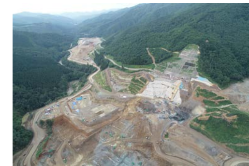
右岸（施工状況） 2019年9月撮影
