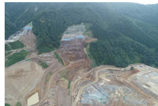
左岸（施工状況） 2019年9月撮影
