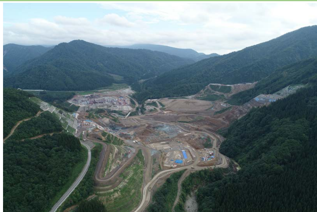
ダムサイト全景（下流より）2019年9月撮影
