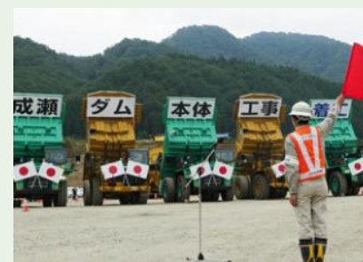
【着工式風景（ダンプアップ）】 着工号令を行う寺内次長
