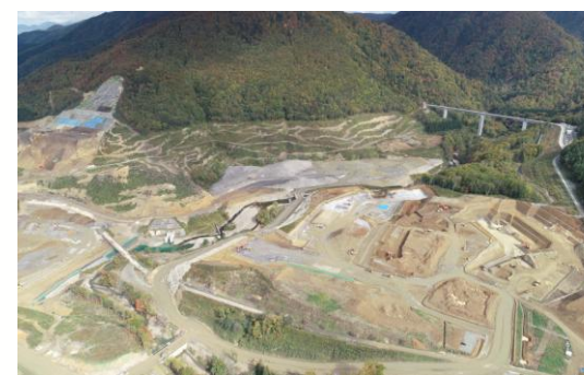
赤滝右岸 表土処理・材料採取工事
